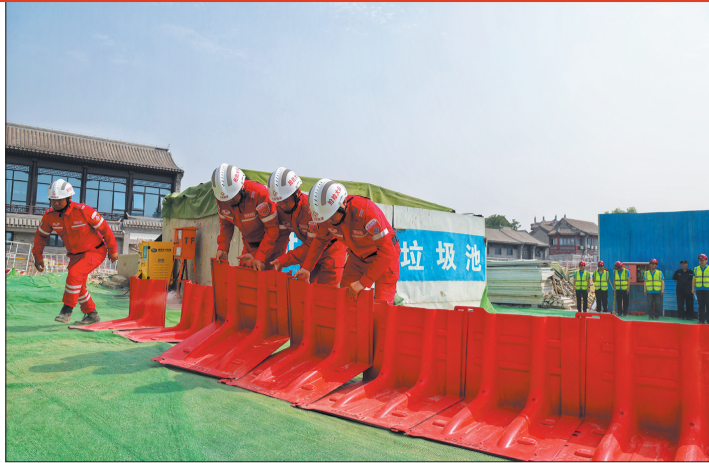
建设工程防汛演练。
